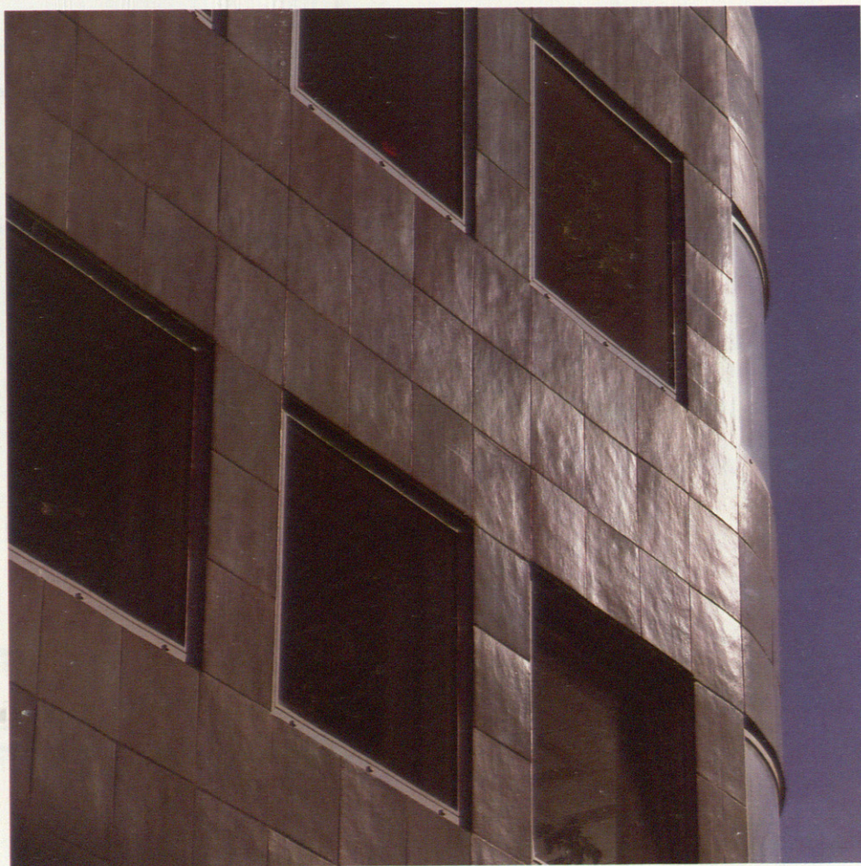
3,4. Detalles de fachada.
